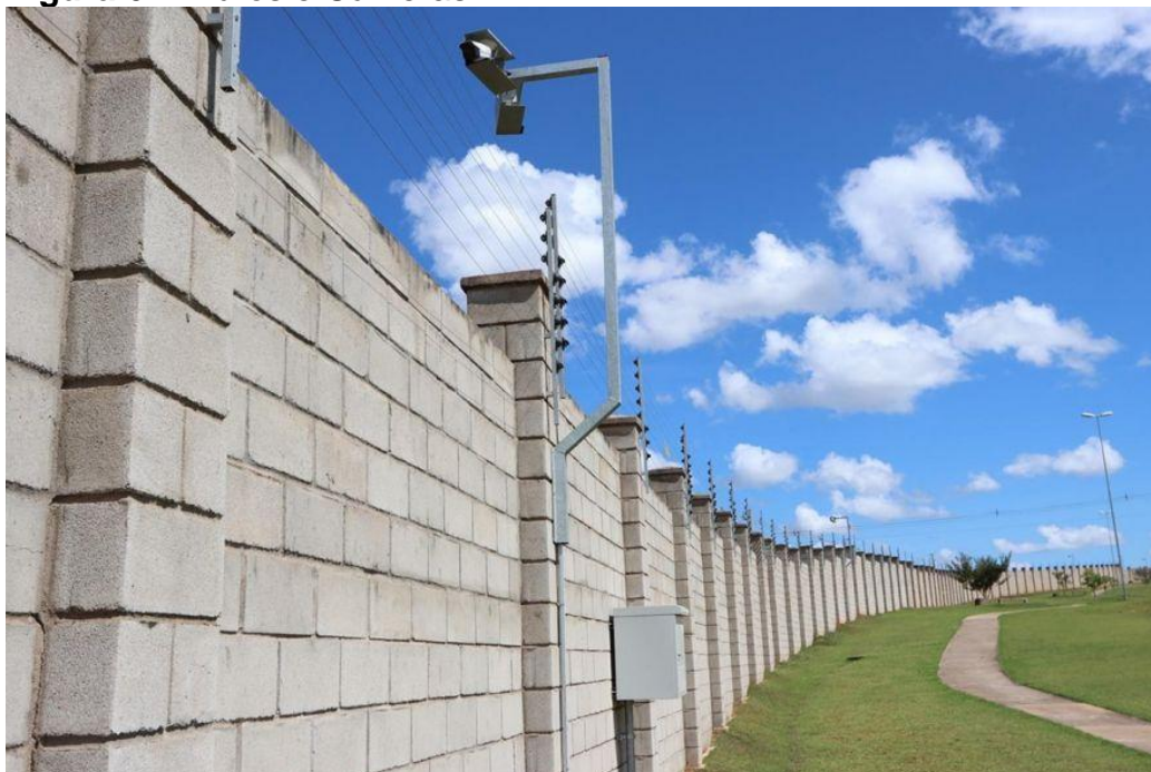
Figura 6 – Muros e Câmeras.
