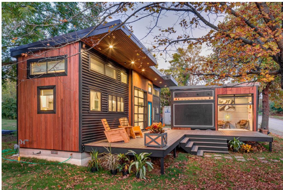
Figura 2 – Tiny House fixa apoiada em fundação radier
