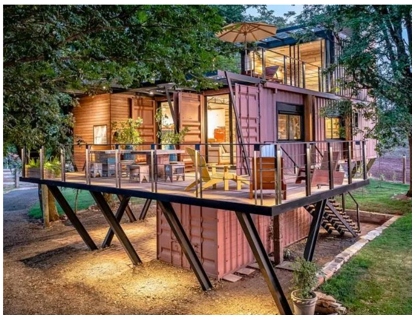
Figura 5 – Tiny House transportável apoiada em fundação pilotis
