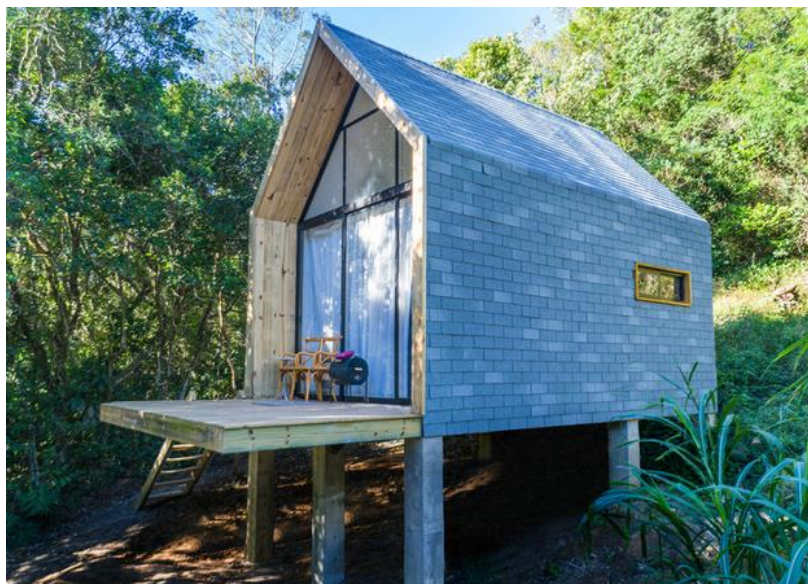
Figura 4 – Tiny House fixa apoiada em fundação pilotis
